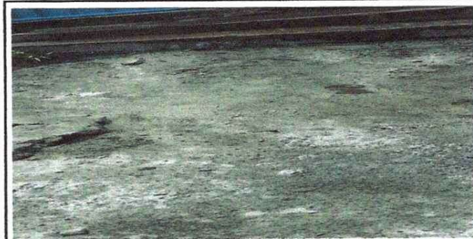
Foto 4: MÓDULO 2 PATIO: LOSA DE PATIO: Reparación de planchas de concreto de patio
