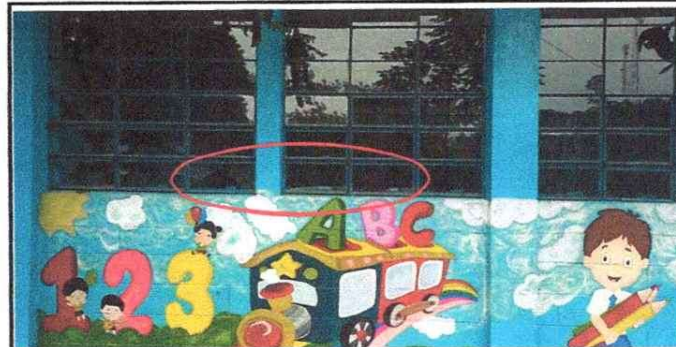
Foto 6: MÓDULO 3 AULA: VENTANA: Sustitución de vidrios
