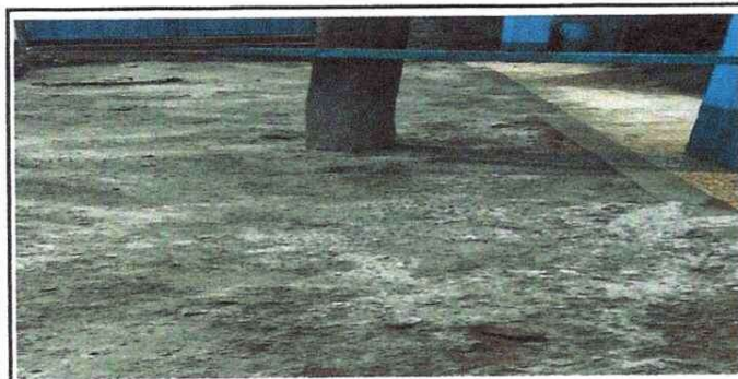
Foto 5: MÓDULO 2 PATIO: LOSA DE PATIO: Reparación de planchas de concreto de patio
