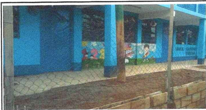
Foto 3: Foto 1: MÓDULO 1 MURO: MUROS PERIMETRALES: Reparación de muro perimetral de block con tubo hg y malla galvanizada, soleras intermedias y columnas.
