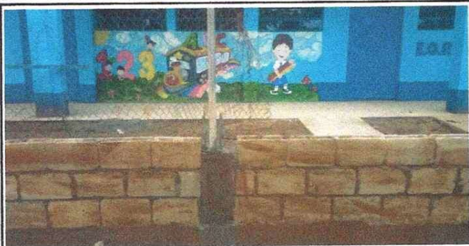
Foto 1: MÓDULO 1 MURO: MUROS PERIMETRALES: Reparación de muro perimetral de block con tubo hg y malla galvanizada, soleras intermedias y columnas.
